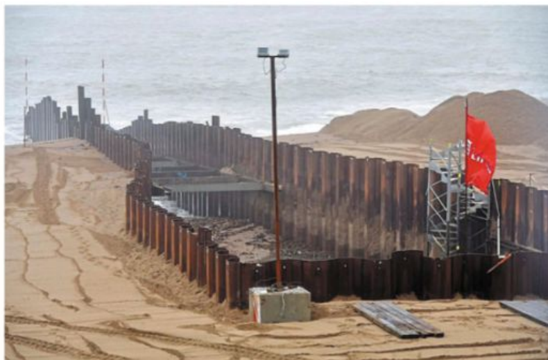
La vaste tranchée sur la plage de la Courance, la zone où déboucheront à terre les deux câbles sous-marins.
